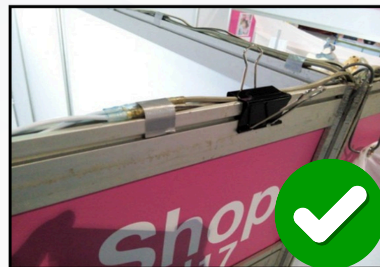
หนีบห่างจากจุดต่อสายไฟ
